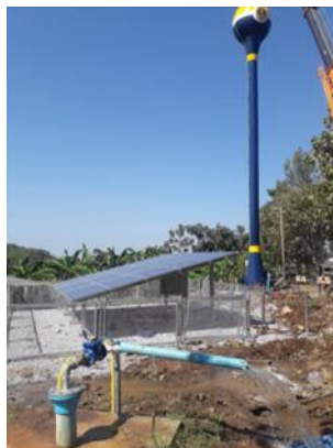
ระบบสูบน้ำ มีภาพน้ำ
